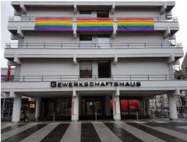
Gewerkschaftshaus des DGB in Nürnberg 2019
